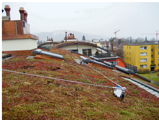
Abb. 6: Ausstattungsstufe 2; Seilsicherungssystem auf begrüntem Tonnendach
