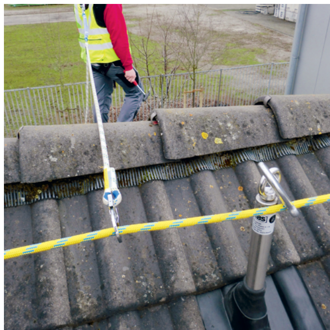
Abb. 9: Temporäres Seilsystem mit Kernmantelseil EN 1891
