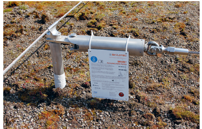
Abb. 24: Objektspezifische Anlagebeschriftung
