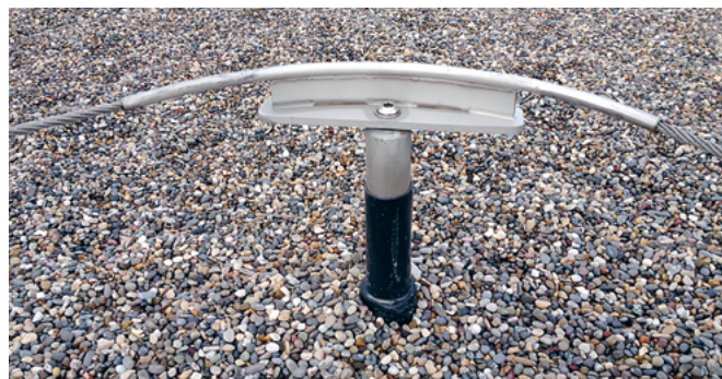
Abb. 6: Frei überfahrbarer Eckpunkt
