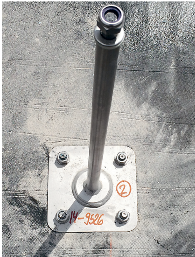
Abb. 23: Befestigungspunkt fertig montiert und für das Protokollfoto beschriftet mit Jahreszahl, der Objektnummer des Herstellers und einer fortlaufenden Nummer
