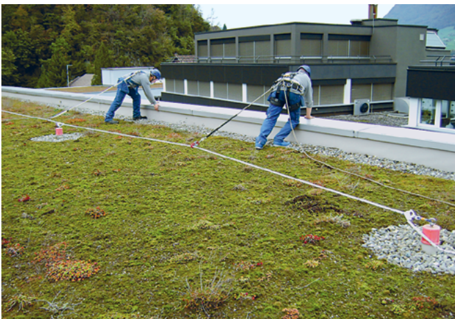
Abb. 10: Temporäres Seilsystem mit Karabinerhaken an EAP befestigt
