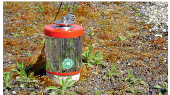
Abb. 25: Objektspezifische Anlagebeschriftung mit Prüfvignette
