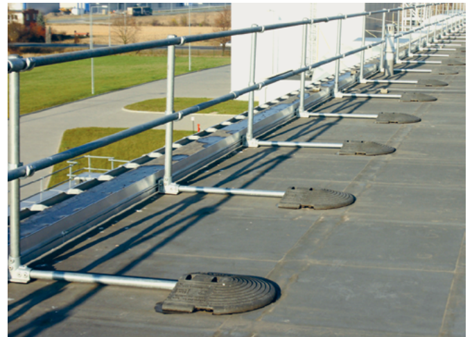
Abb. 16: Ausstattungsstufe 3: Seitenschutzsystem mit Auflast
