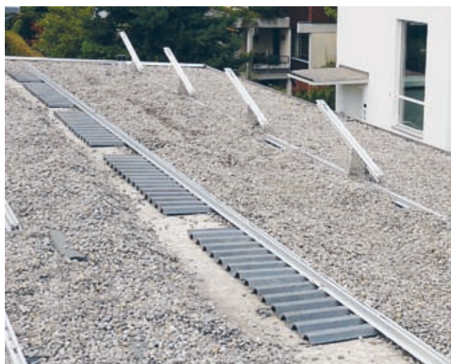
Einbau der Flachdachaufständerung und Beschweren der Druckverteilungsplatten mit Rundkies
